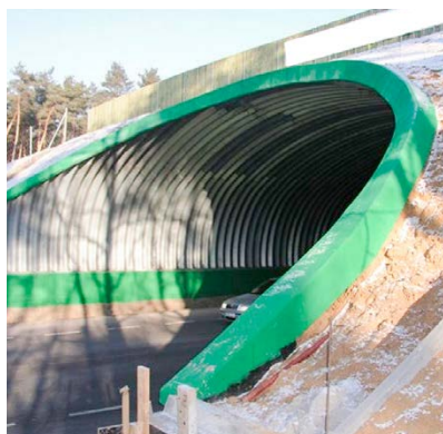
Betonnen frontmuur – talud uiteinde.
