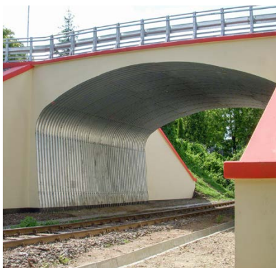
Betonnen kraag – recht uiteinde.
