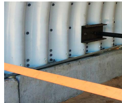
Fig. 8. Aansluiting van de staalconstructie op betonnen funderingen
